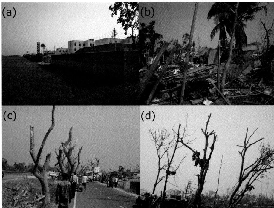
第2図 竜巻によって生じた被害を示す. (a) 刑務所の2重の外壁の倒壊, (b) 全壊家屋が多い村の様子, (c) Brahmanbaria-Akaura 道路の街路樹の被害, (d) 木々に巻きついた飛散物.
