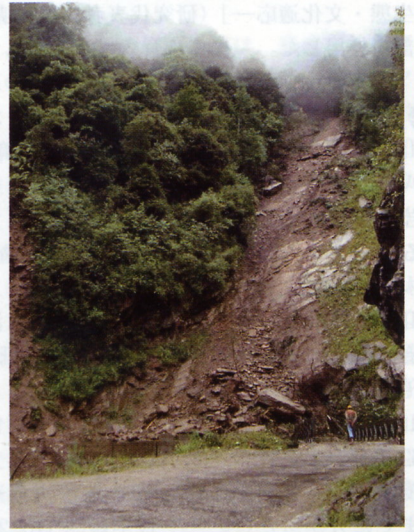
写真2 インド北東部、アルナチャル・プラデシュ州、タワン地域で観察された斜面崩壊（2007年7月23日撮影）
