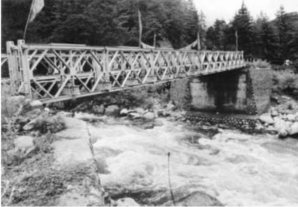
写真4 パイロット事業で建設した橋、ブムタン県
