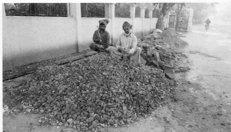
図12-9 道路補修用のレンガ造り
