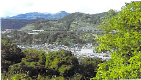
写真：山北町 中心部、山の斜面を東名高速道路が通る
