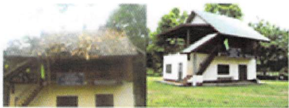
写真3. 資料館の屋根修理 (左:破損した屋根、右:修理後)
