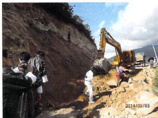
写真3 工事中の道路
