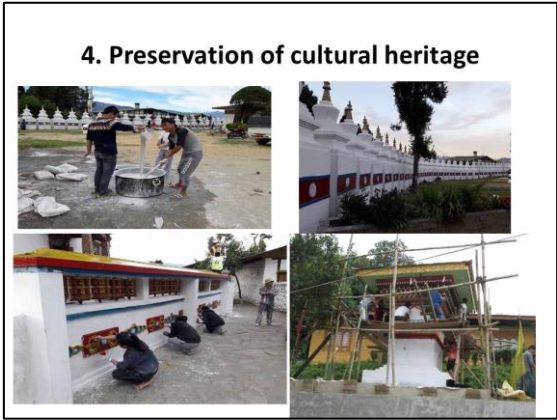
5) 仏塔などの修繕活動（塗装）
