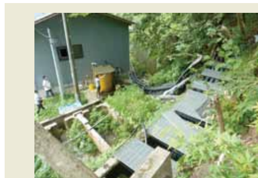
総会の翌日(9月2日)、京都府南丹市美山町「芦生山の家」の小水力発電施設を見学。パイプで水をひき、6メートルあまりの落差を活用して13キロワットの出力。「山の家」の30%程度の電力を賄えるという。かつては、この場所に京都大学の水力発電設備があった。
