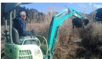
重機でカヤ株を掘る。
