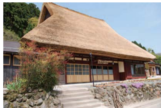
写真2 改修・整備された「おっきん椋川交流館」（写真提供：田中耕司、2009年5月2日）
