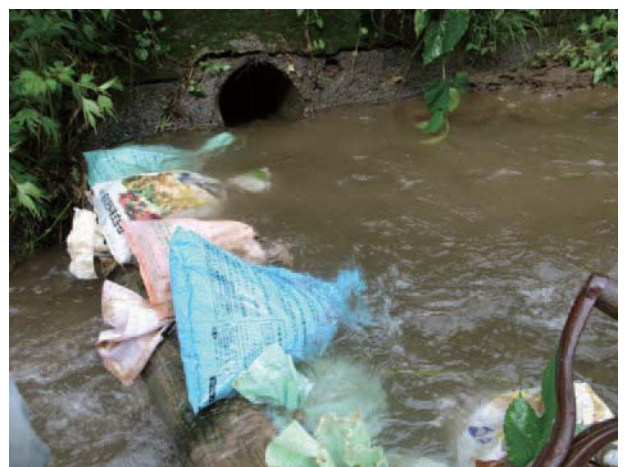
写真 6 川に作られた取水口であるユ。肥料袋などに砂利を入れた土嚢を積んで堰をつくる
